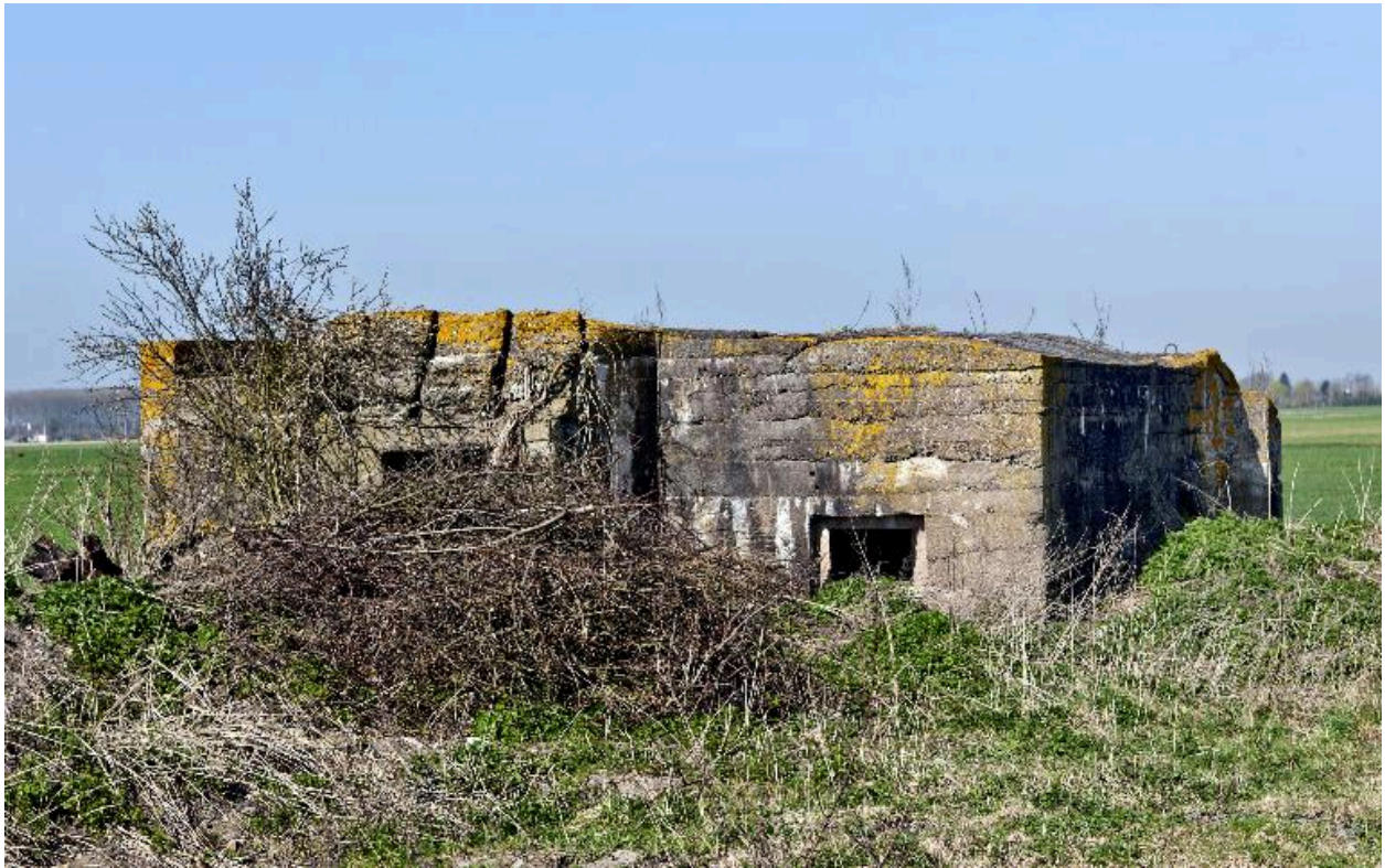
vue de trois-quarts vers le nord-ouest
