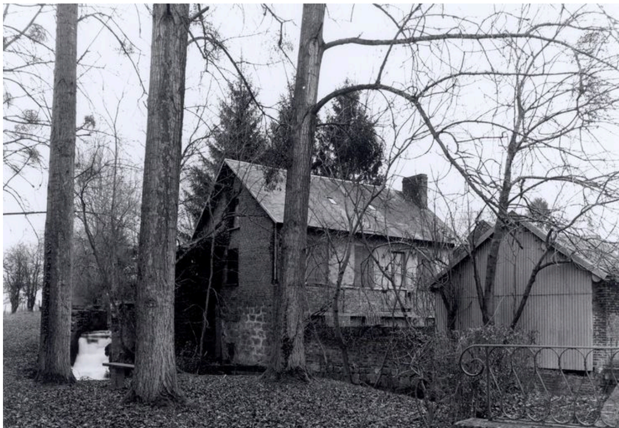
Vue d'ensemble du moulin.
