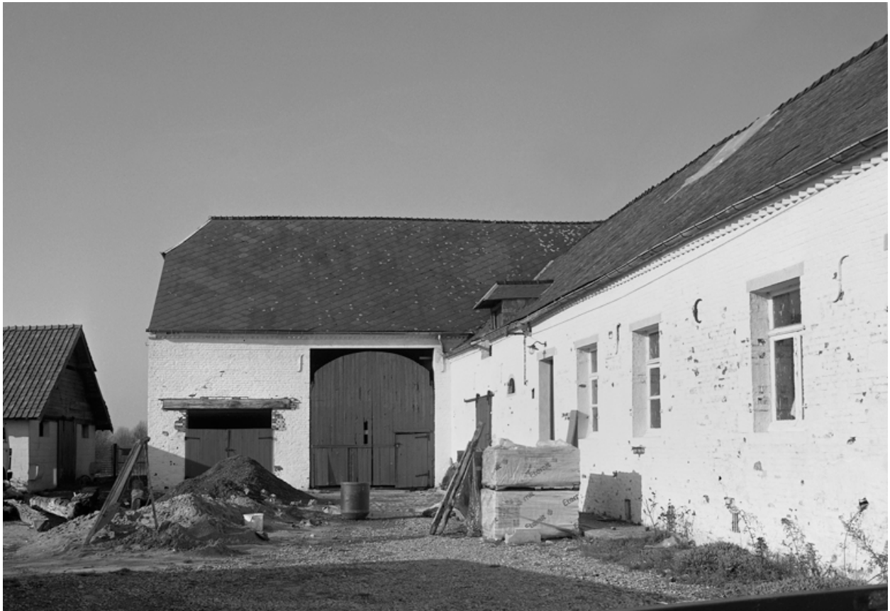
Vue partielle du logis et de la grange.
