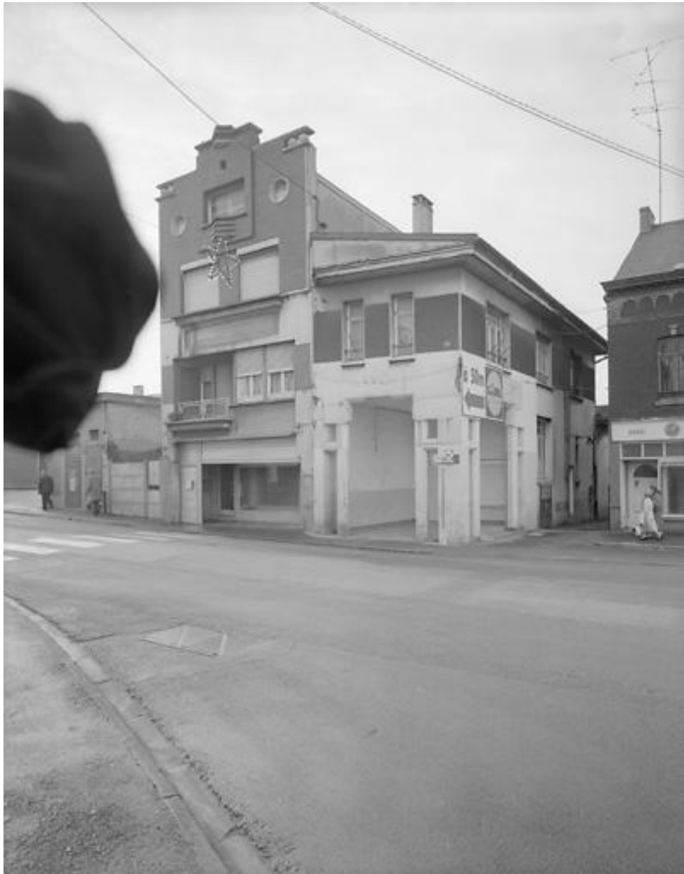
Vue générale des bains-douches.
