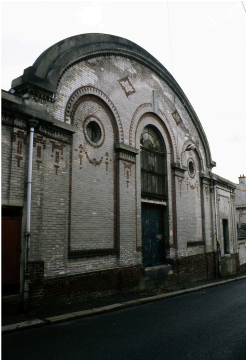
Façade de la teinturerie (rue de la Grange), 2001.
