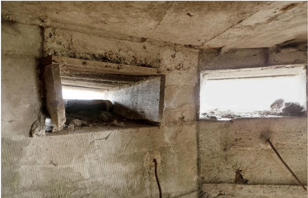
Détail de coffrage dans une des embrasures
