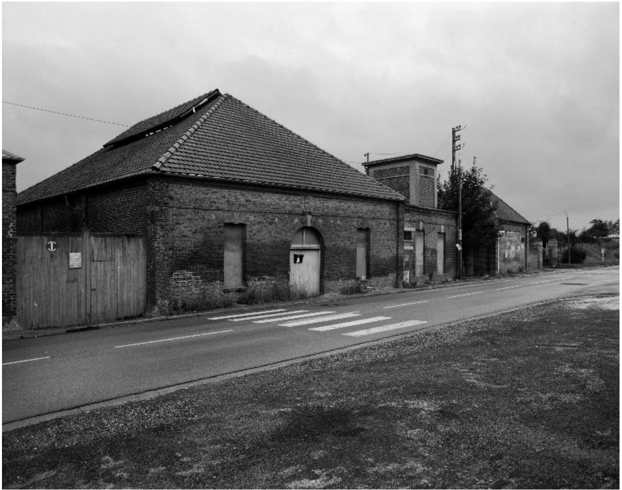
Vue depuis la rue Joliot-Curie (ancienne rue de Woincourt), en 1988 : ancien atelier (détruit).
