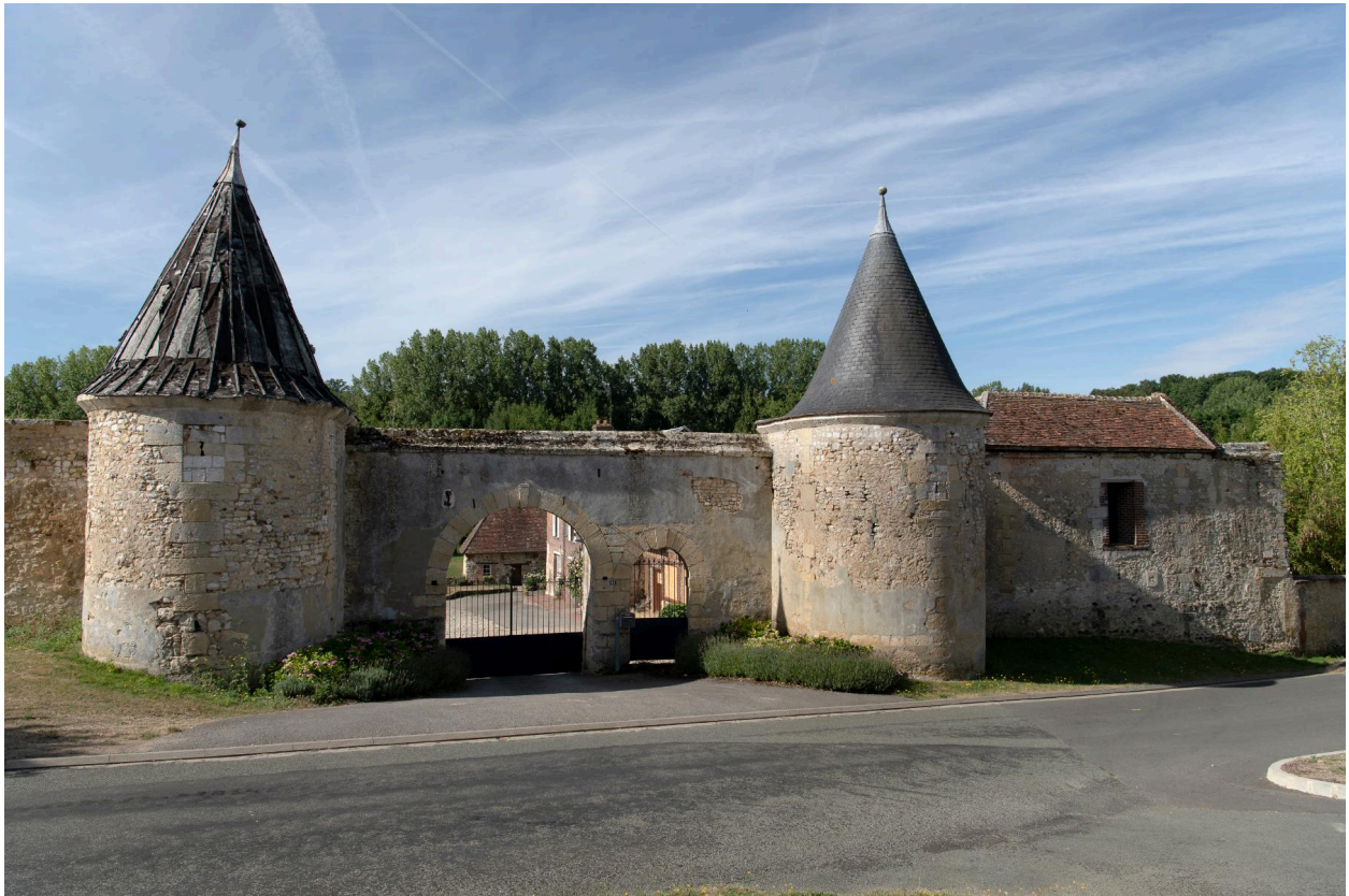
Entrée de la ferme de Ponceaux, vue depuis le nord (inscrite MH PA00114759).
