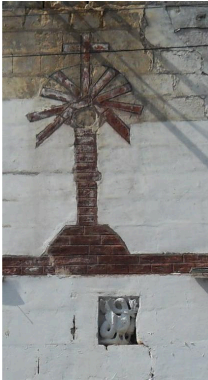
Décor du pignon en calcaire, d'une maison reconstruite, rue de Vignacourt.
