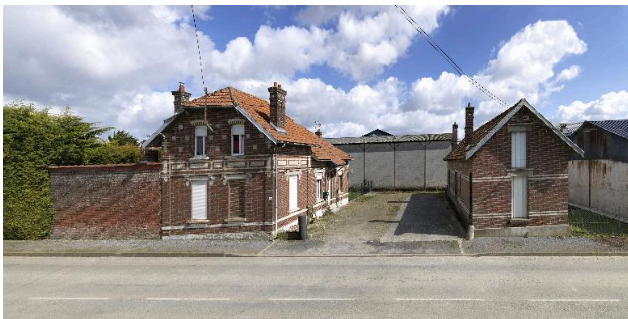
Logement de contremaître et bureau de pesée, vue de face.
