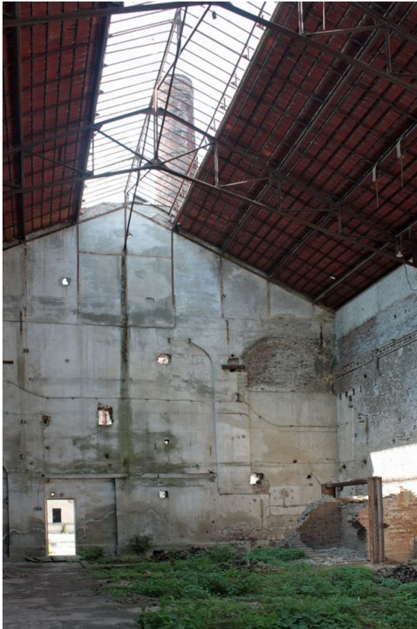
Intérieur de l'ancienne chaufferie.
