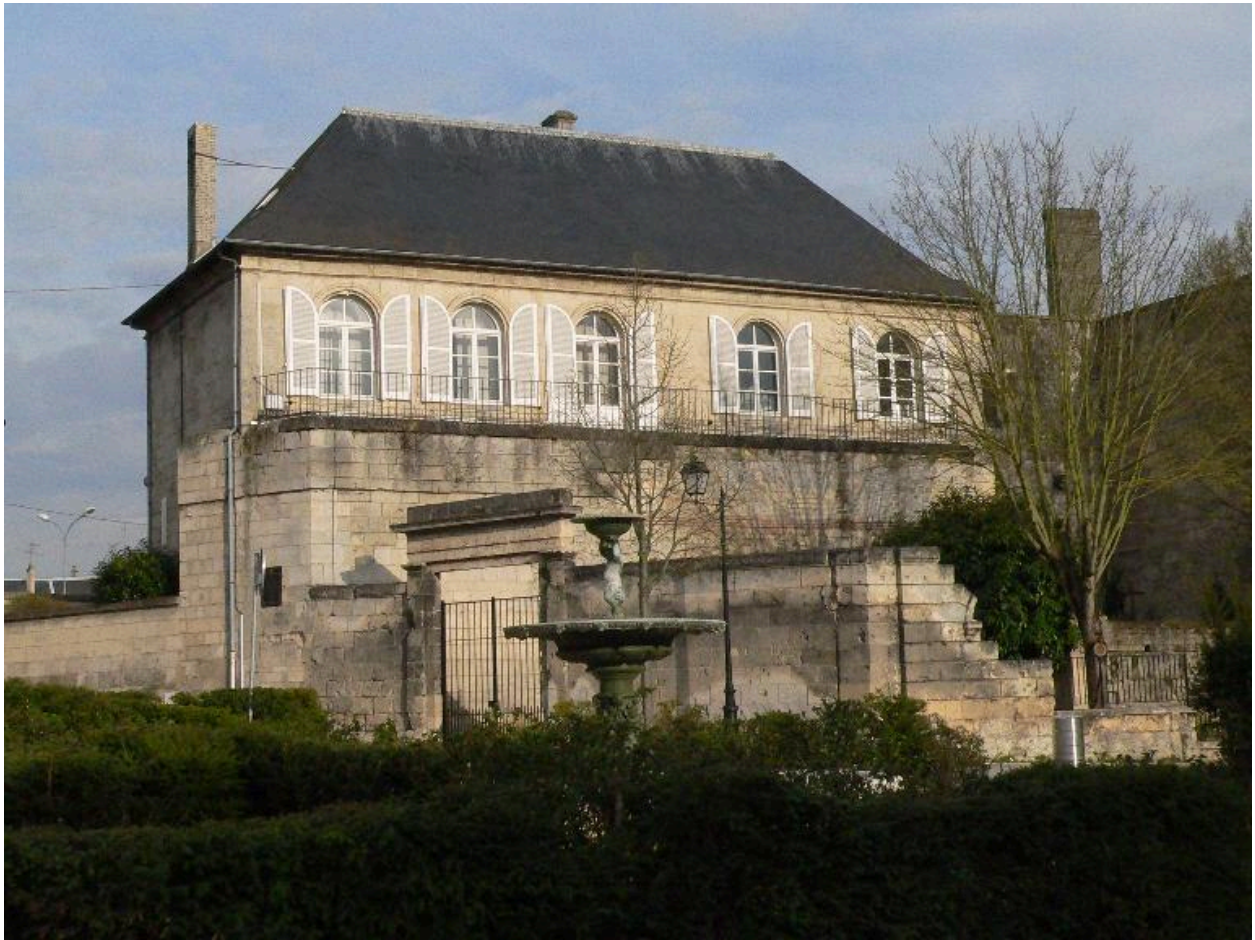
Vue d'un bâtiment subsistant de l'évêché.
