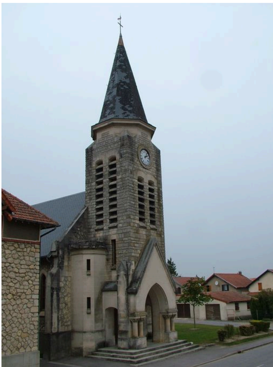
Vue de la façade ouest.
