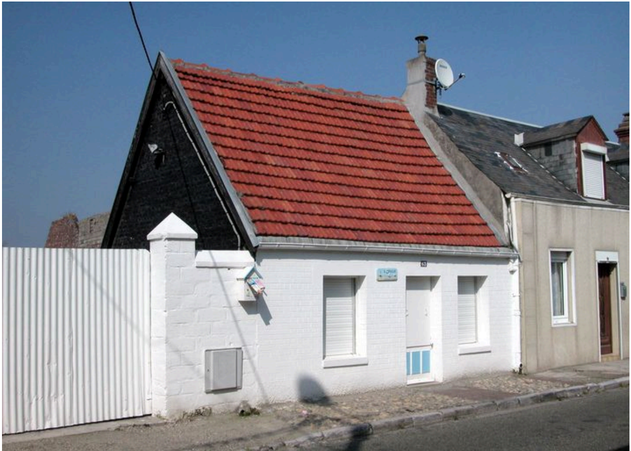
Maison ancienne, 63 rue Anatole-Mopin.
