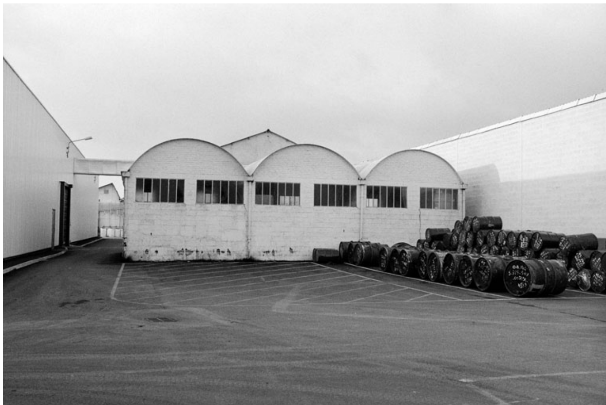
Magasin industriel, flanc est.
