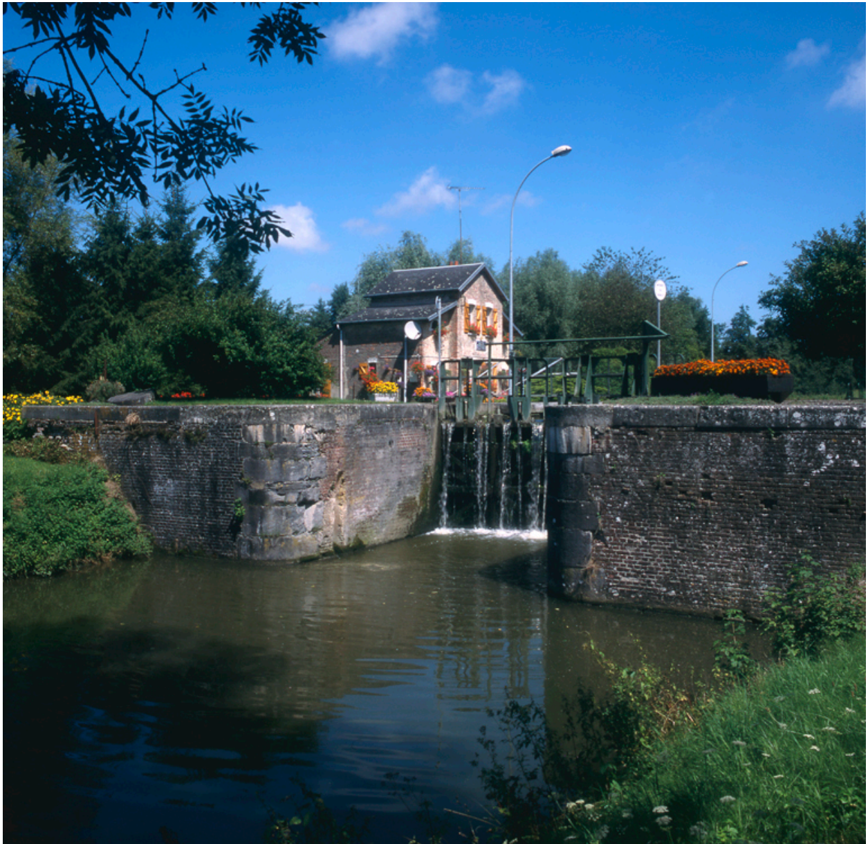
L'écluse de Tupigny, sur le canal de la Sambre à l'Oise.
