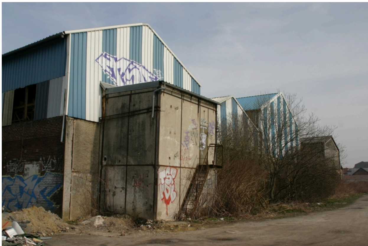
Pignons sud des ateliers, le long du Canal de Saint-Quentin.
