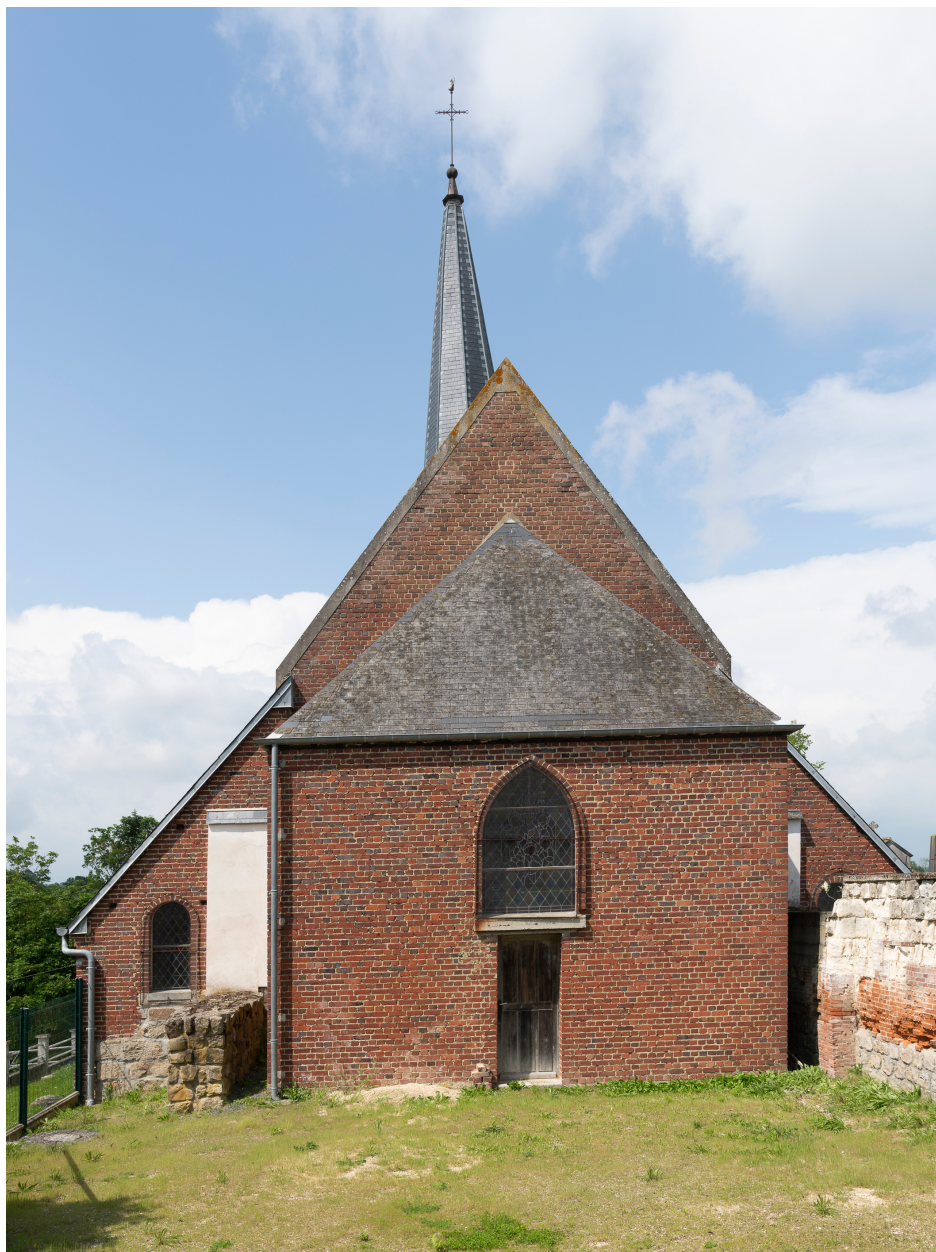
Chevet et vestiges des murs de l'ancien chœur.
