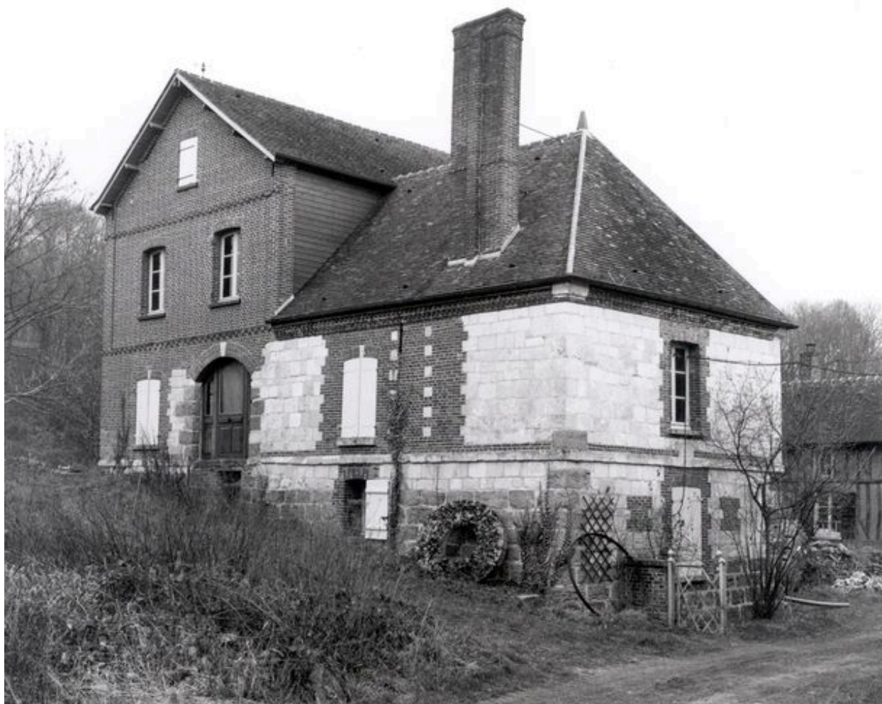
Vue d'ensemble du moulin à farine et du logement de meunier en retour.
