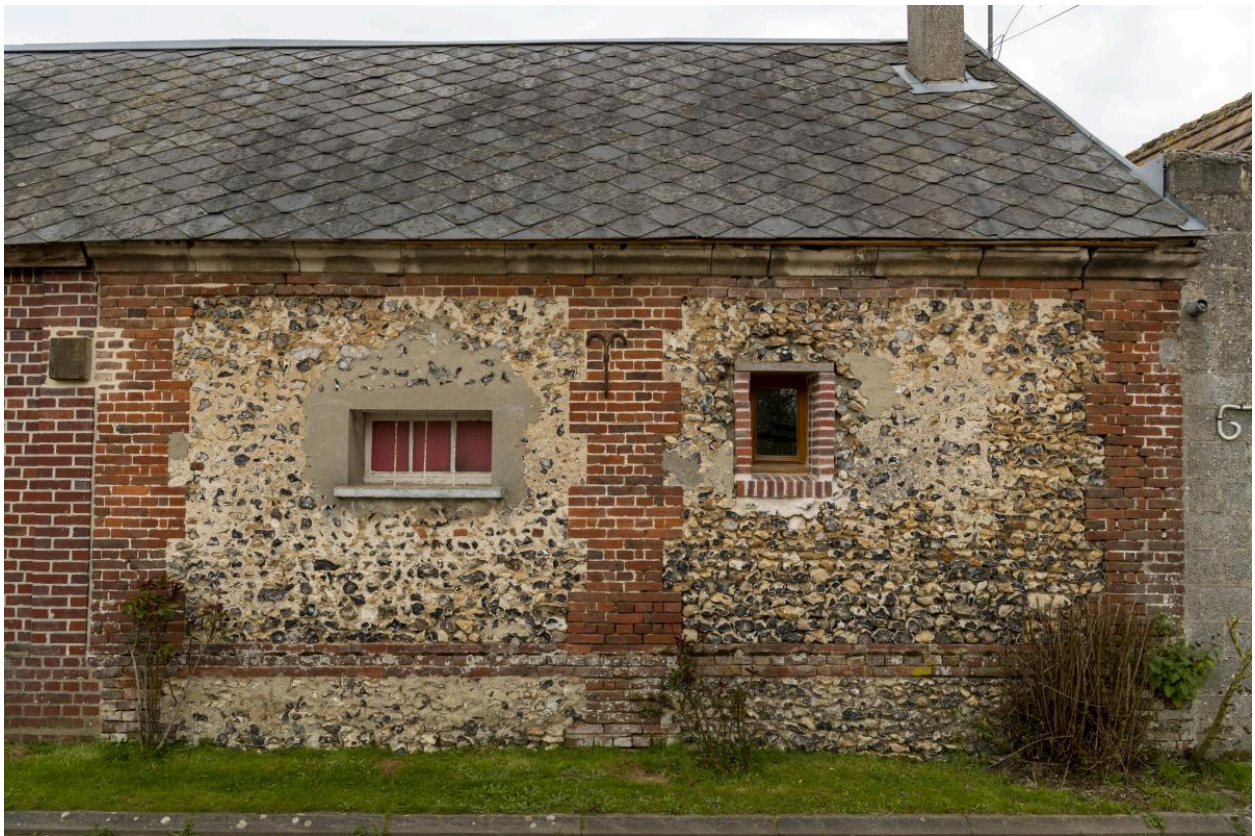
Bâtiment en brique et moellon de silex, n°13 rue du Byon, vue depuis le nord-ouest.
