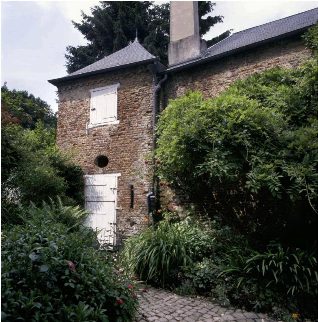
Vue de la petite écurie bâtie sur le côté droit de la cour.
