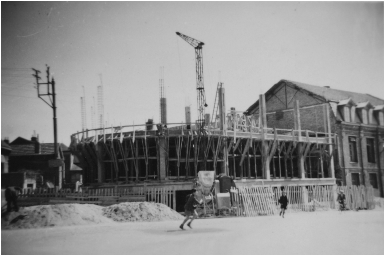
Chantier de construction des ateliers, 1948 (IFA).
