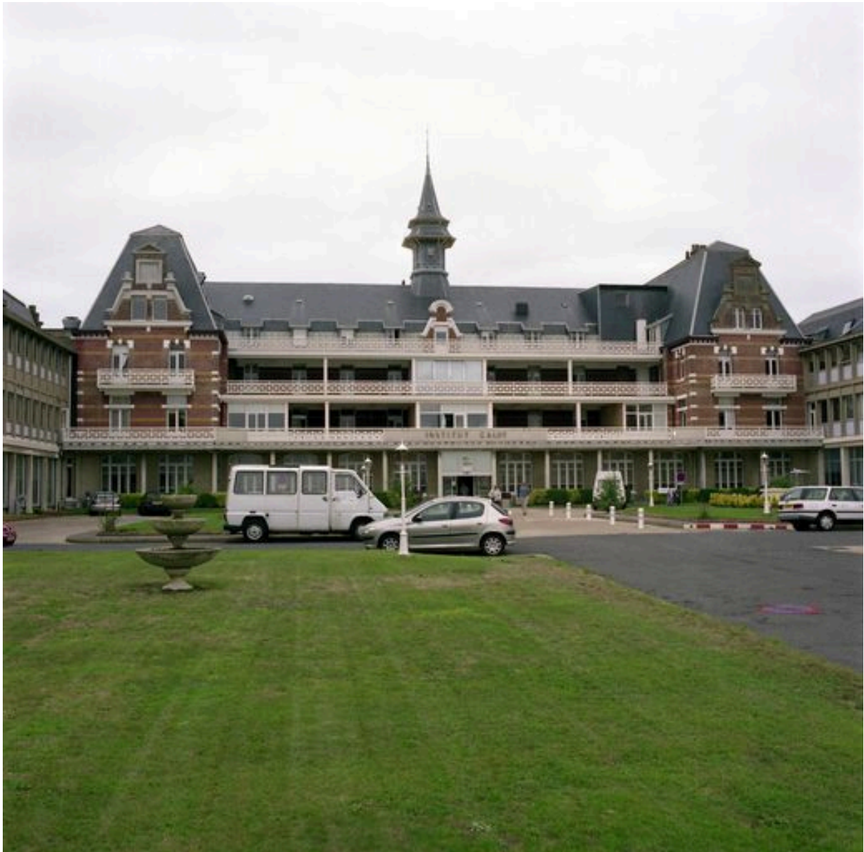
Corps de logis principal de l'établissement primitif, élévation sur la cour, vue de face.
