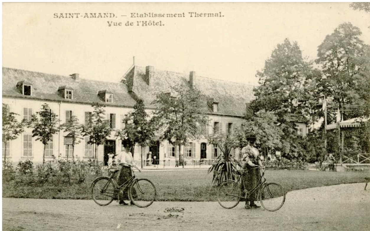
Vue générale de l'hôtel avant l'incendie de 1907, carte postale (Médiathèque Saint-Amand-les-Eaux).
