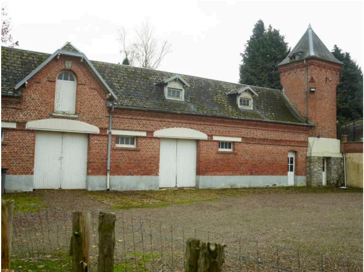
Vue des étables et du pigeonnier depuis la cour.
