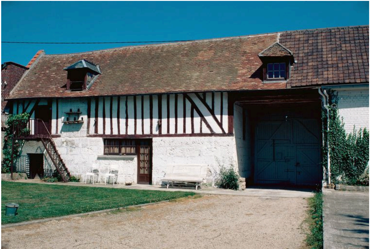
Elévation antérieure de la grange d'une ferme repérée.
