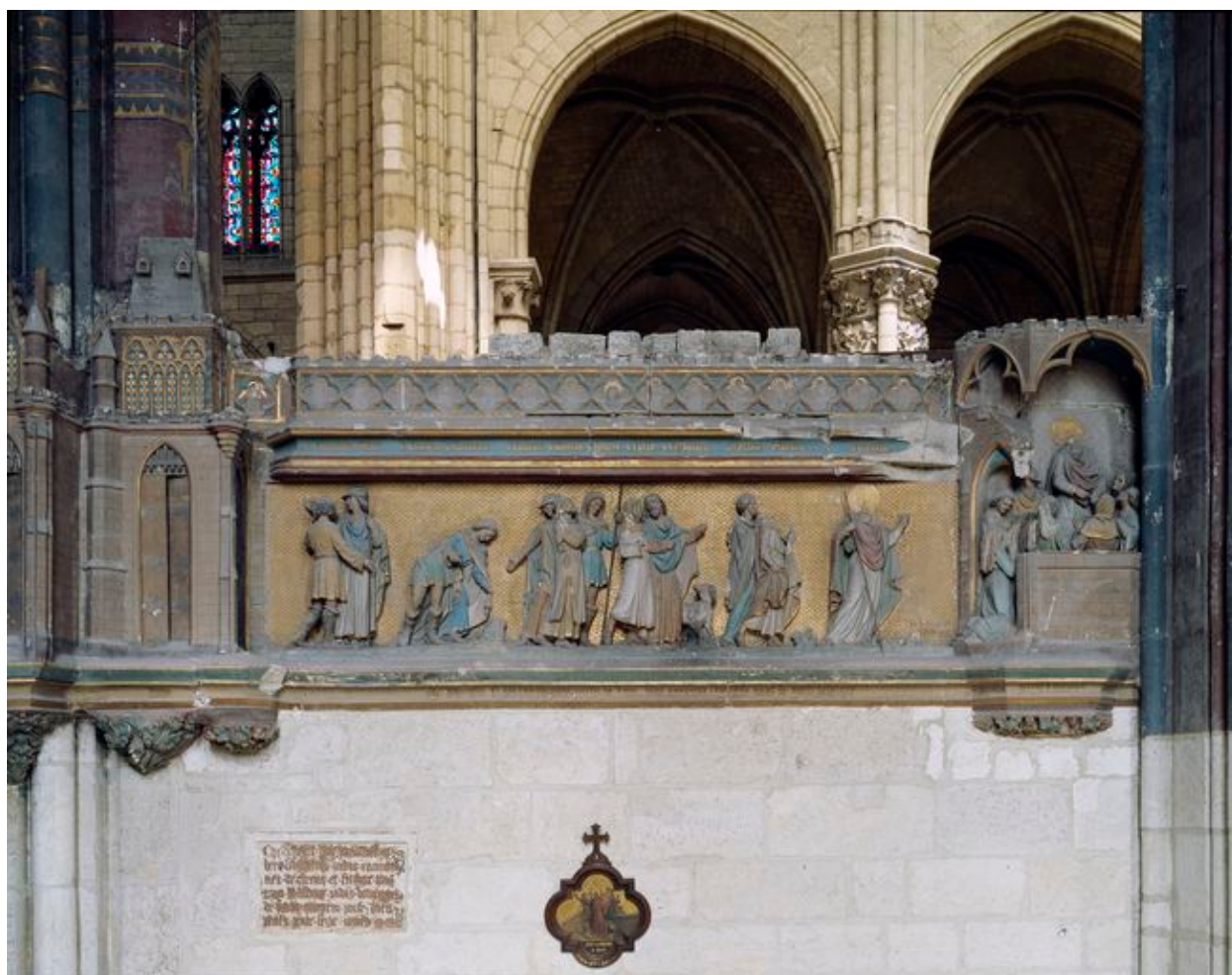
Vue de la première travée sud.
