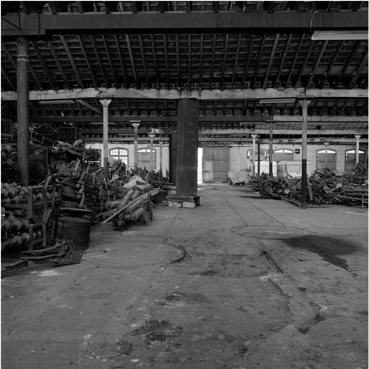
Atelier de blanchiment (E). Au centre un étai de fortune, au sol les anciens rails et rotondes à wagonnets.
