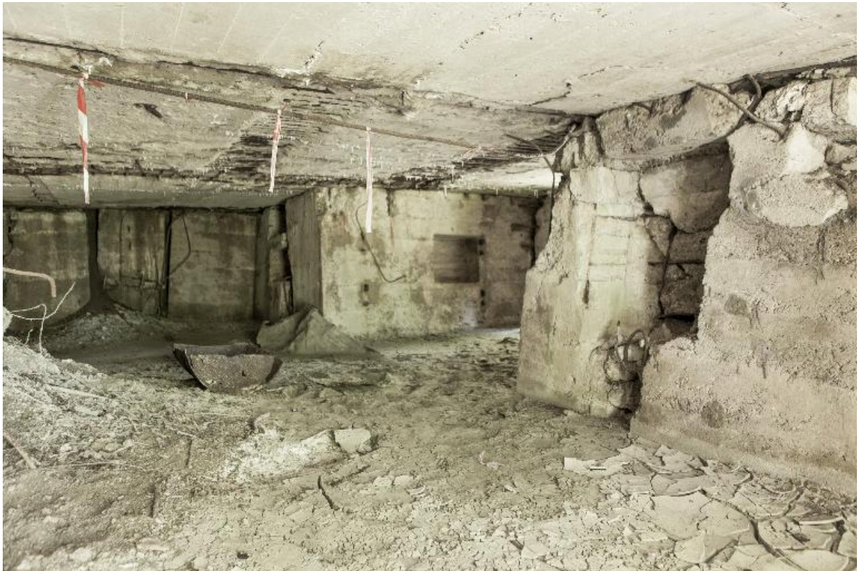
Vue intérieure depuis l'entrée sud
