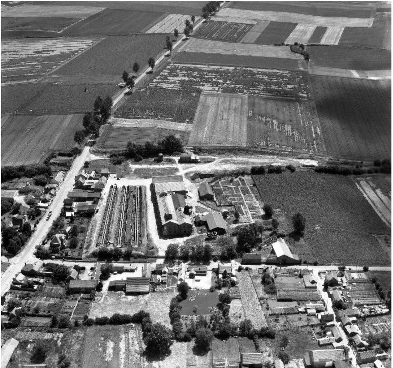
Vue aérienne, flanc nord.
