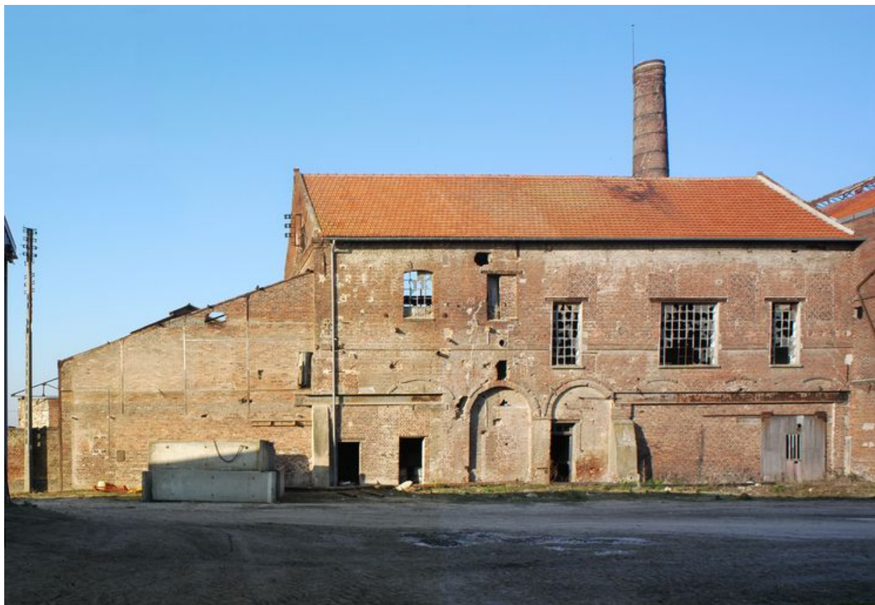
Façade arrière (est) de l'atelier de fabrication
