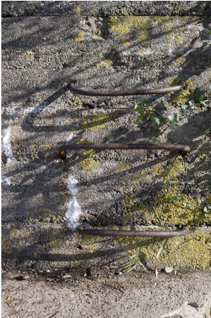
Echelons métalliques donnant accès au couvrement
