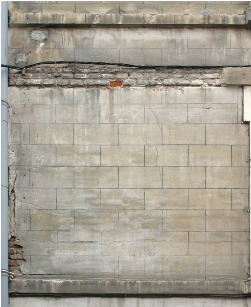
Maçonnerie de briques enduites.
