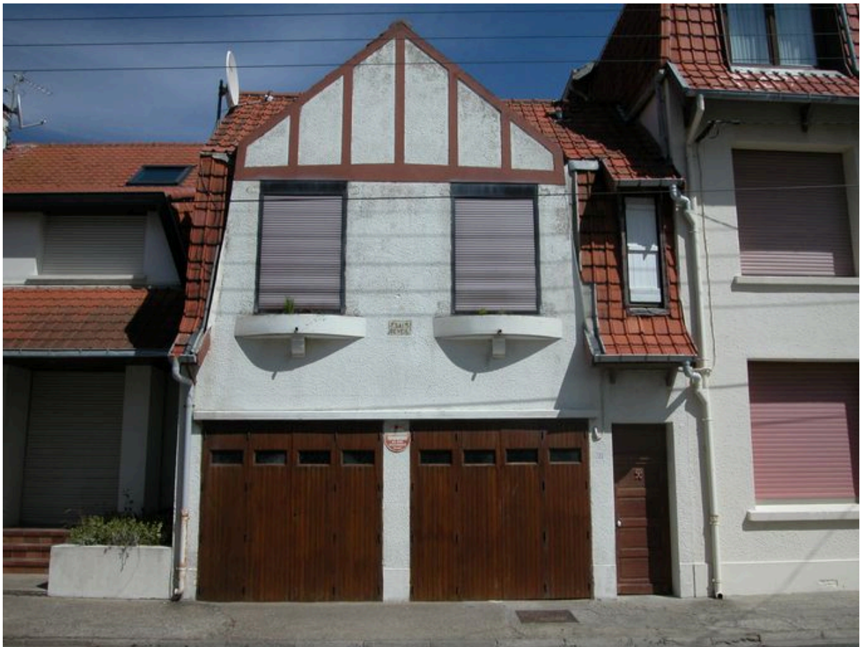
Garages avec logements à l'étage (Gai Réveil, 31 rue de Paris).
