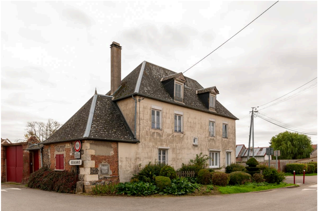
Ancien presbytère, vue depuis le nord
