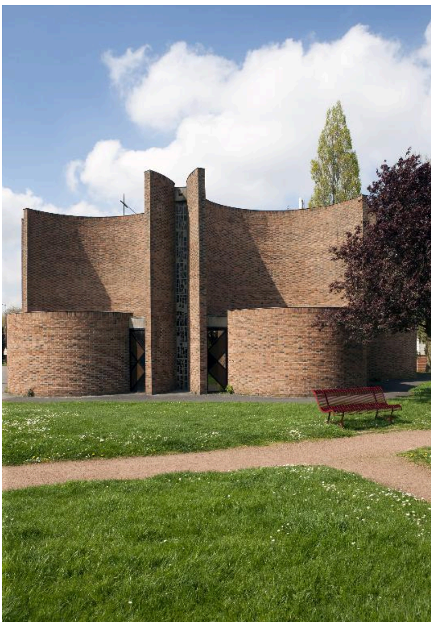
Élévation nord-est de l'église.
