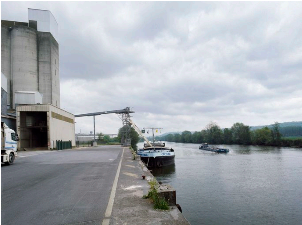
Cellules de stockage et quais de transbordement au bord de l'Oise.
