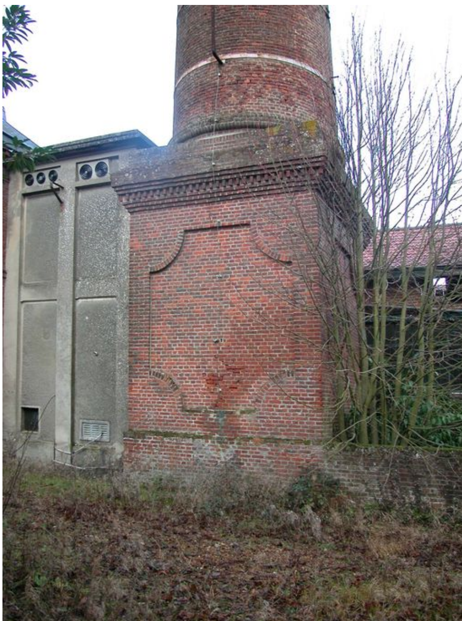
Le socle de la cheminée d'usine.
