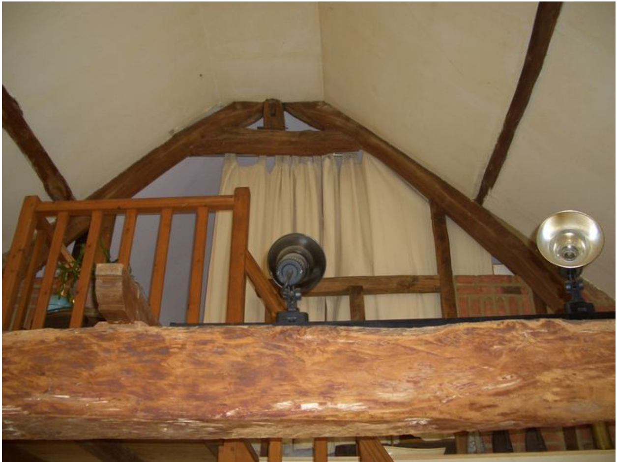
Vue d'une ferme de la charpente.
