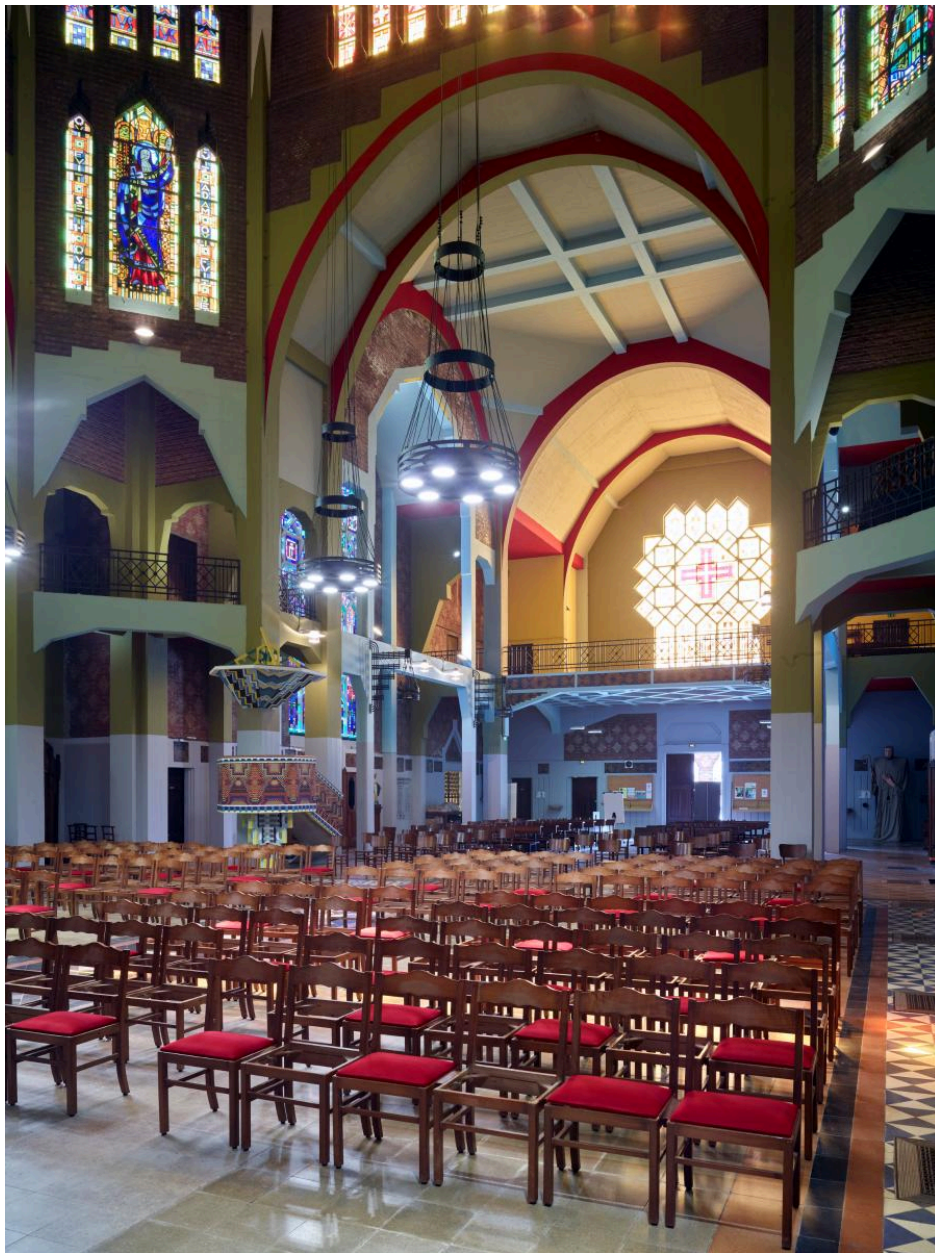
Vue d'ensemble intérieur de la nef vers l'ouest.
