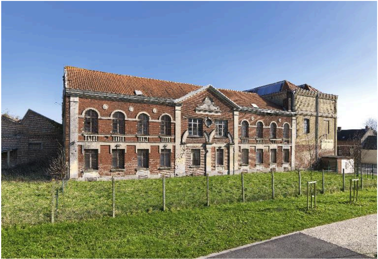
Façade ouest de l'atelier de pliage.
