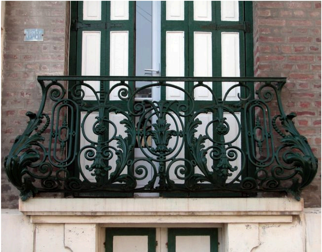
Détail du décor de fonderie des garde-corps des balconnets du rez-de-chaussée surélevé.
