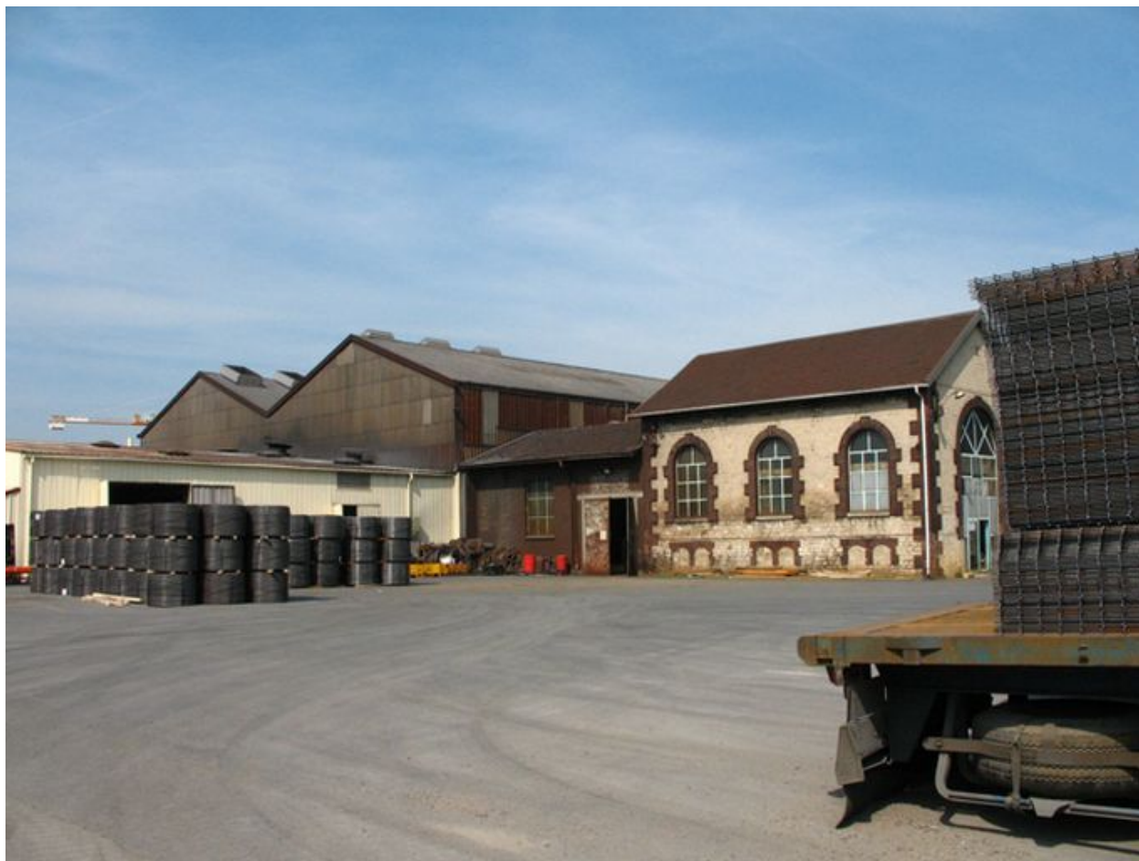
Les bâtiments de stockage des bobines et le laboratoire contrôle qualité.
