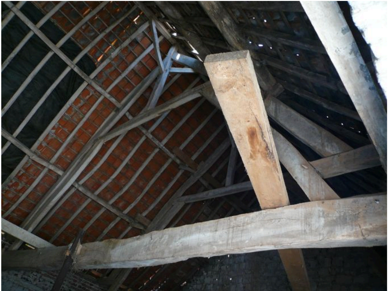
Vue de la charpente de la grange.
