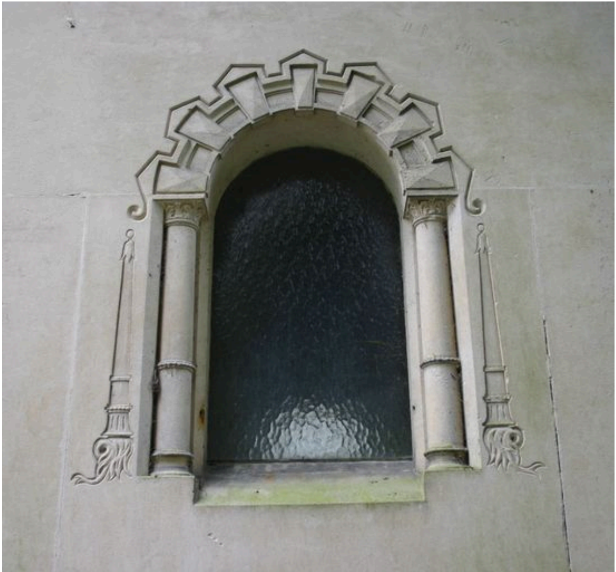
Détail de l'une des fenêtres latérales.
