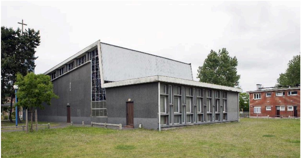
Vue du flanc droit et de la salle paroissiale à l'arrière de l'église.
