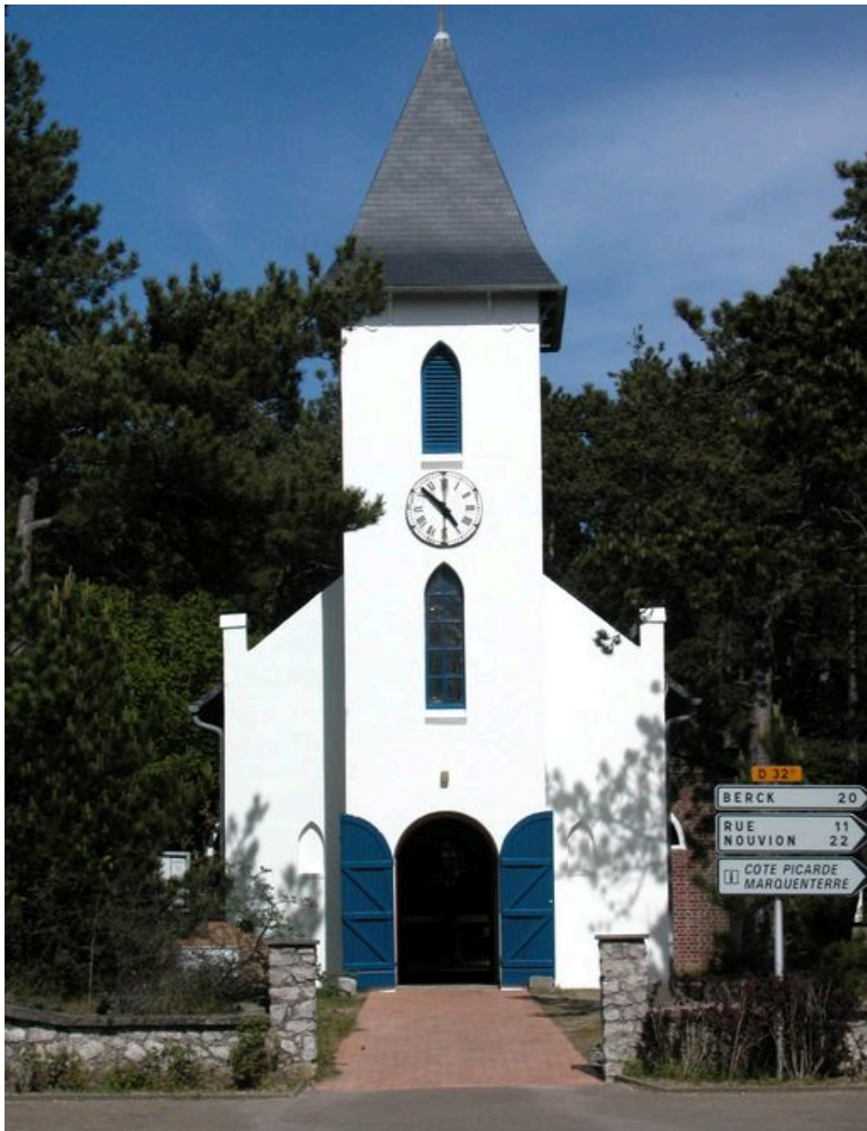
Vue d'ensemble de la façade repeinte.
