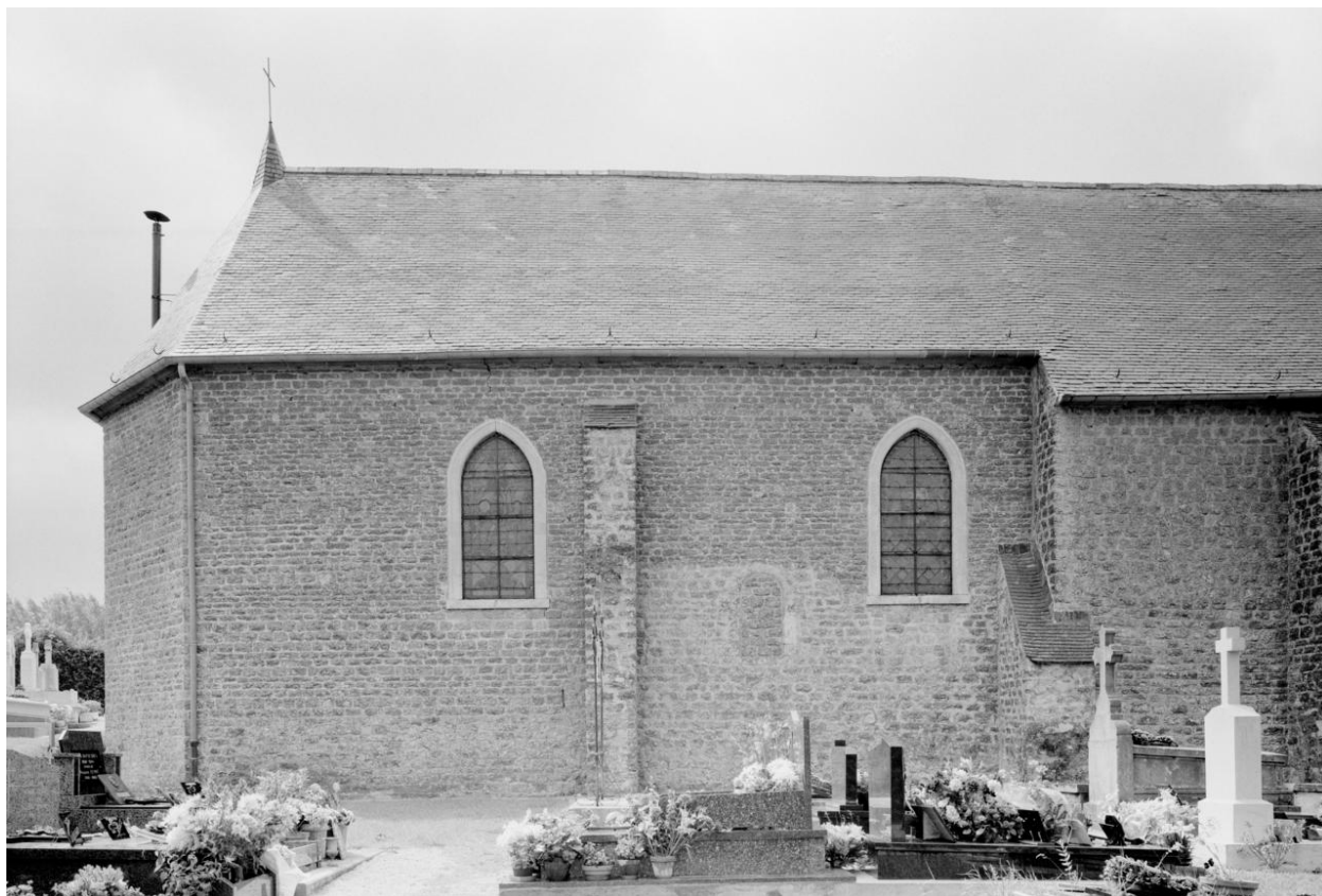
Façade nord (chœur).
