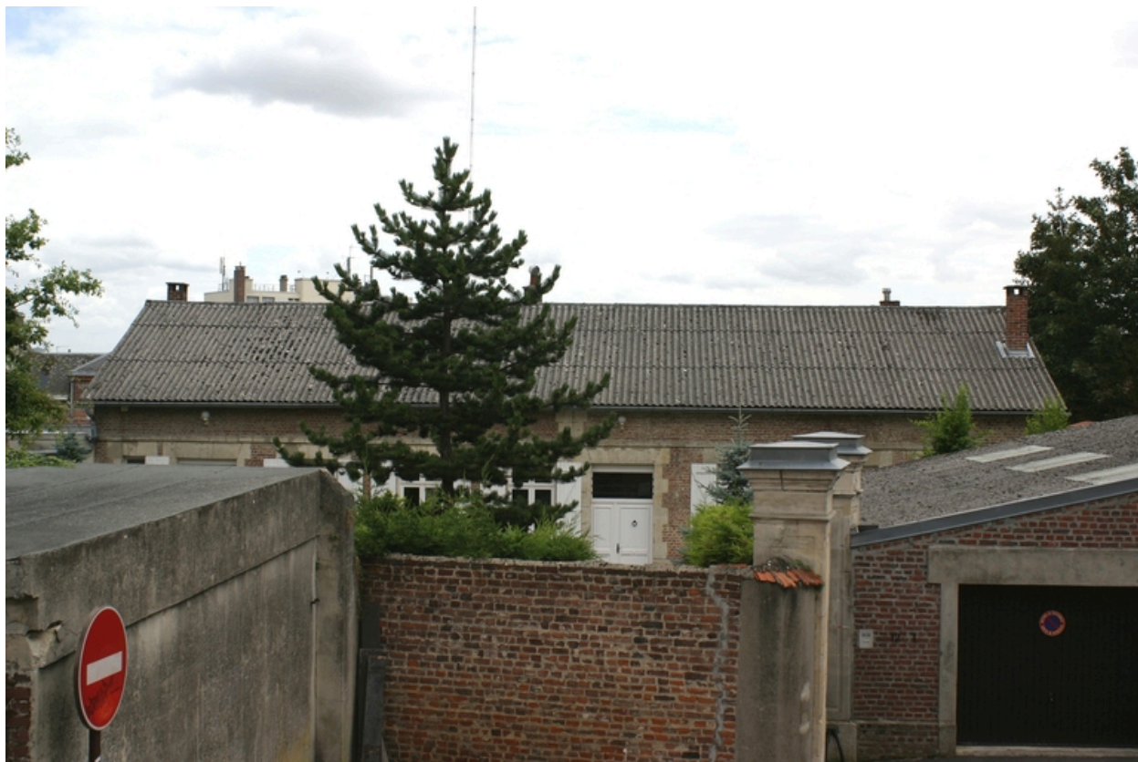
Ancien logement patronal de Paul Aubert, vu du nord-ouest.
