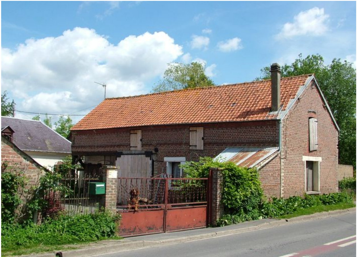
Remise et logement.
